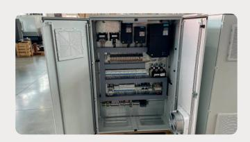
Частотно регулируемый электропривод состоит из трехфазного асинхронного электродвигателя переменного тока с короткозамкнутым ротором и инвентора (частотного преобразователя – далее ПЧ), который обеспечивает плавный пуск, плавную остановку, изменение скорости и направления вращения электродвигателя.
